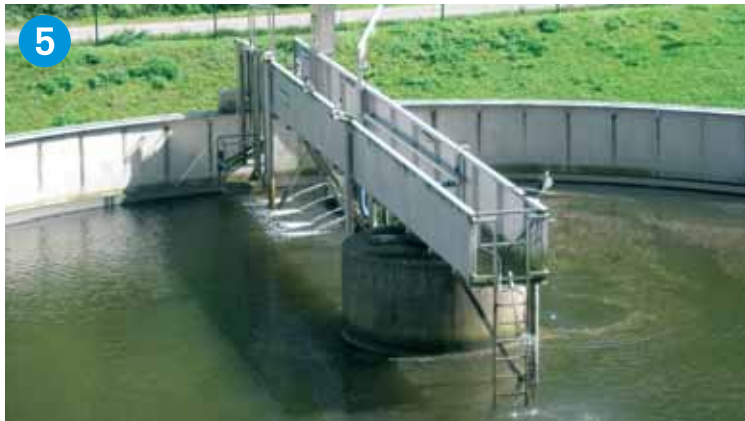
▲ Belebungs- und Nachklärbecken der Kläranlage in Heimbuchenthal, Unterfranken.
